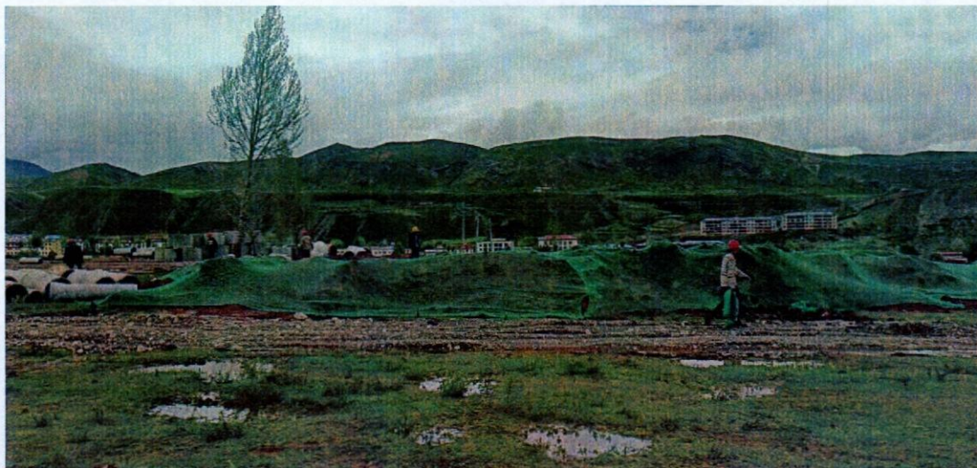
布托路土方覆盖整改后照片：
