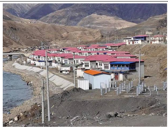
一体化污水处理设施
