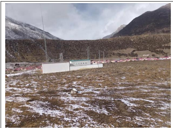
一体化污水处理设施
