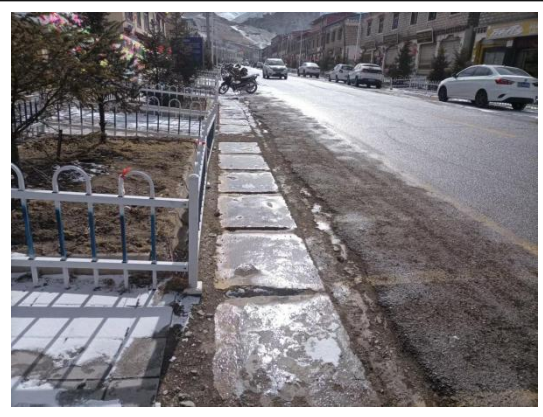
乡镇排水沟渠
